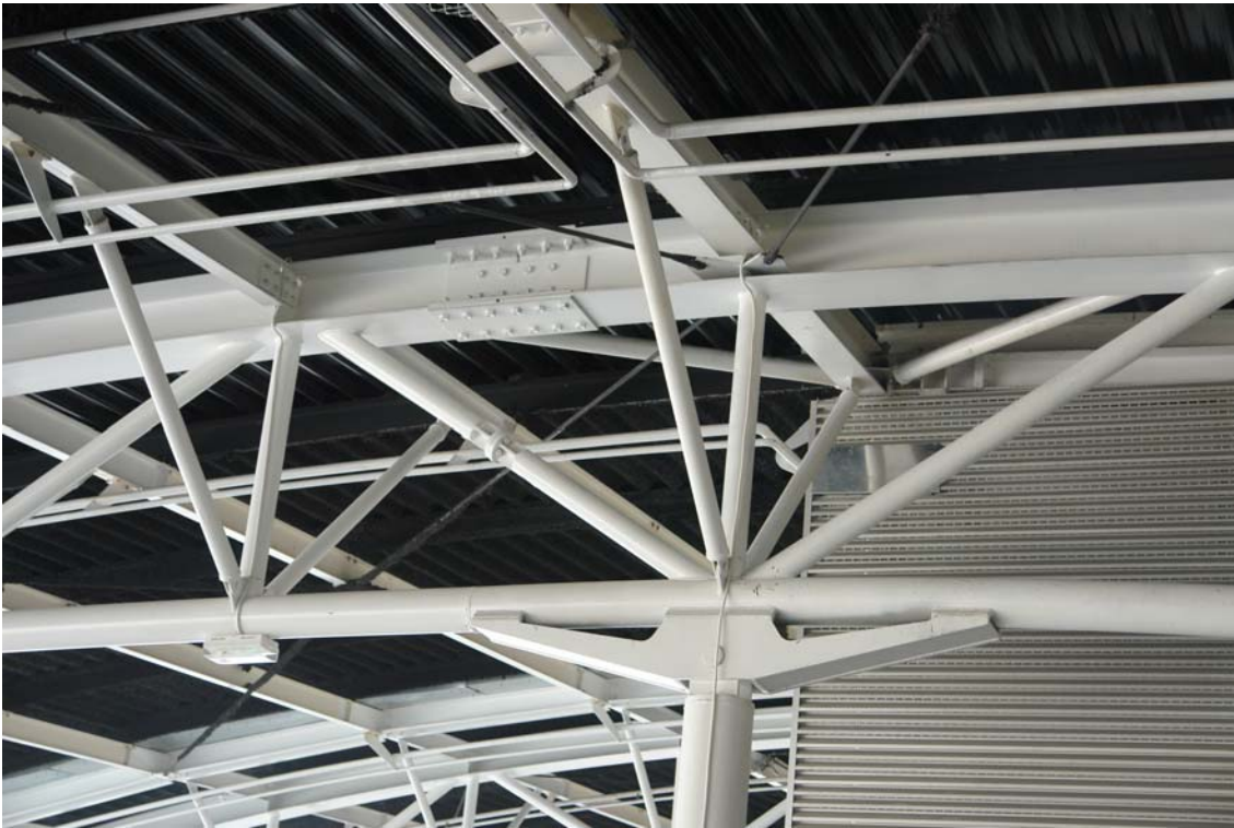
Photo 2 - Charpente de toiture au droit d'un poteau intérieur
