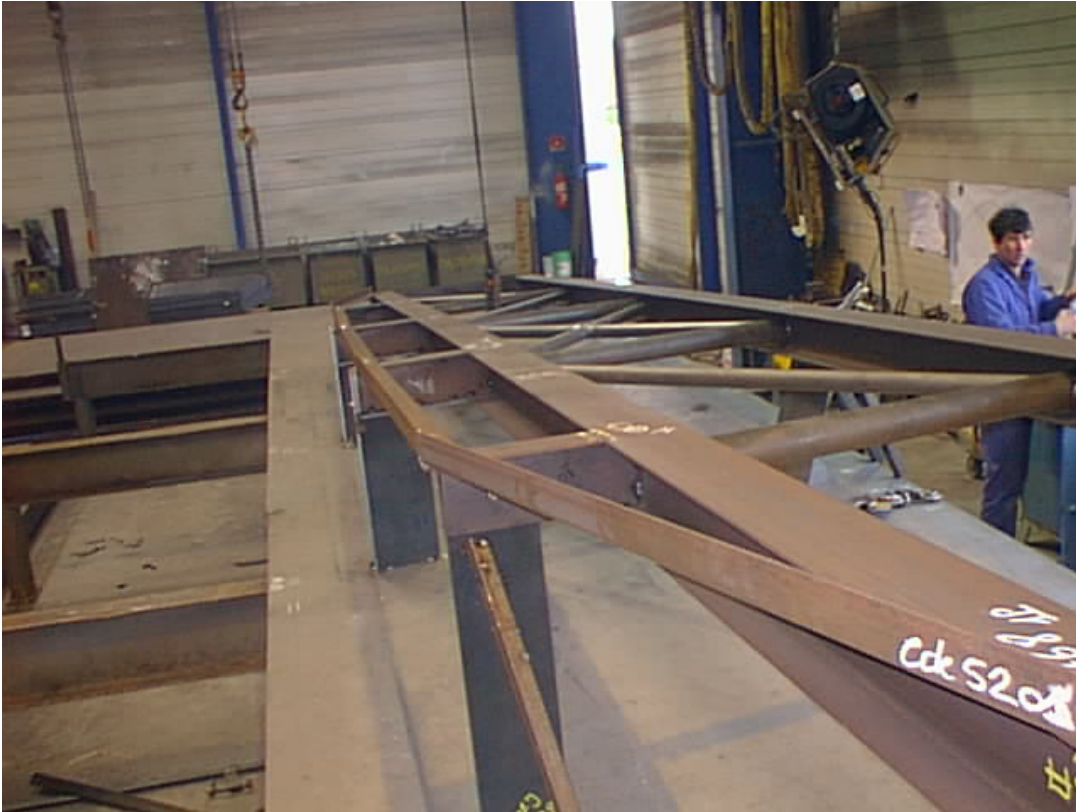
Photo 6 - Assemblage sur gabarit à l'atelier (poutre au vent le long du tarmac)
