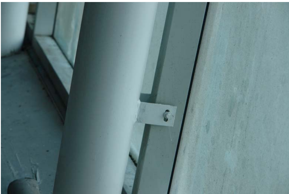
Photo 3 - Attache du verre en dilatation verticale sur le poteau tarmac
