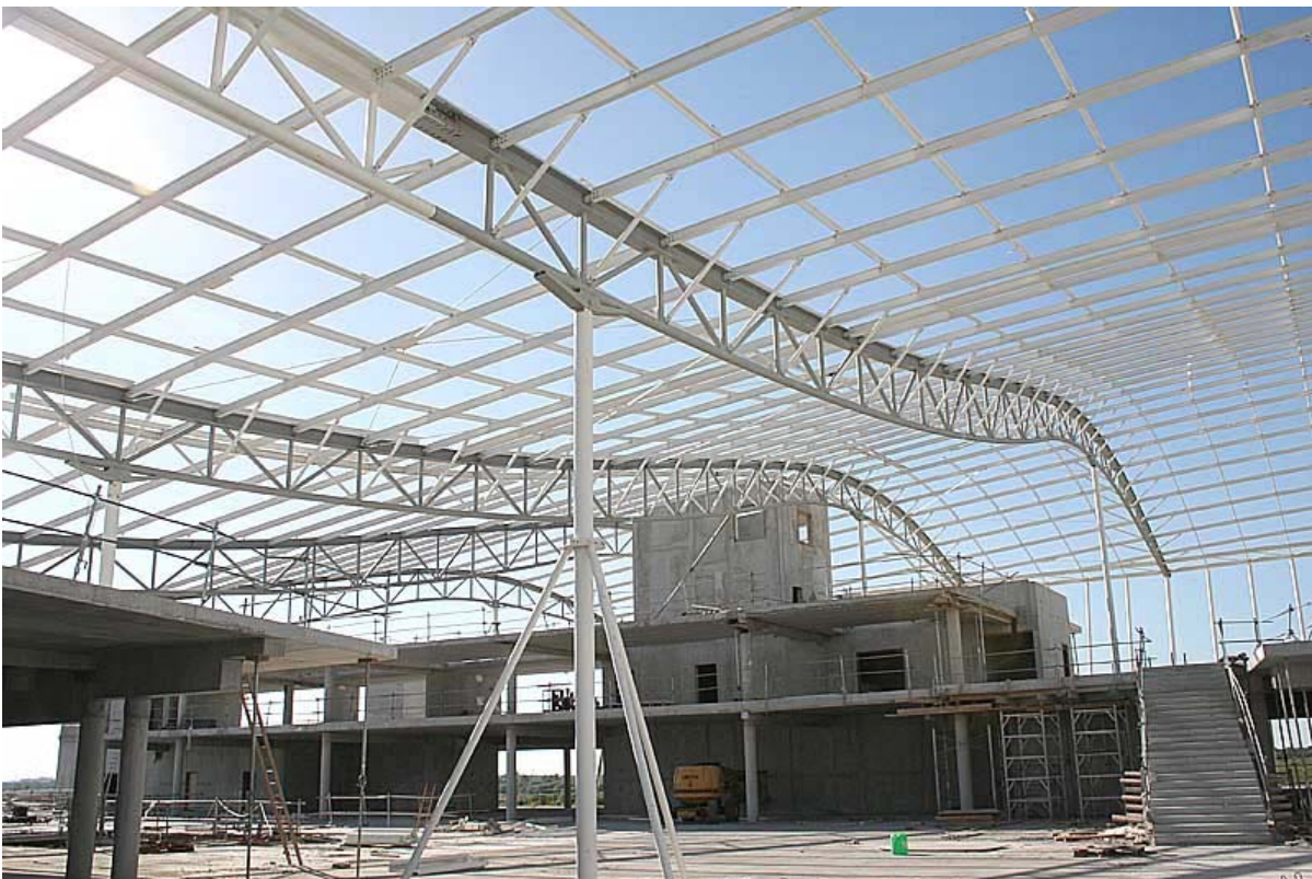
Photo 8 - Montage avancé : poteaux toujours étayés
