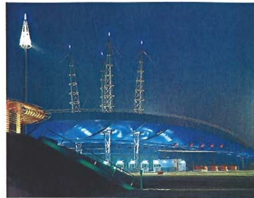
BARRIÈRE DE PÉAGE D'HERQUELINGUE - AUTOROUTE A16 AMIENS - BOULOGNE Maître d'ouvrage, Sanef . Architectes, Dubosc & Landowski . Ingénierie structure et enveloppe, Arcora .
